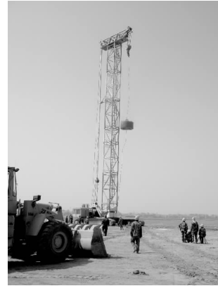
图1 15000kN·m能级强夯设备图
