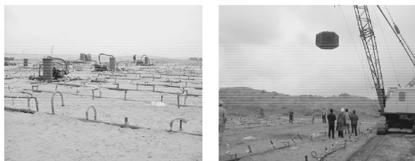
图3 外高桥港区四期工程施工现场
