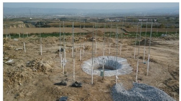
图6 砂井布设完毕后全貌
