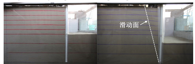
(a) 工况 1 开挖 60 cm
