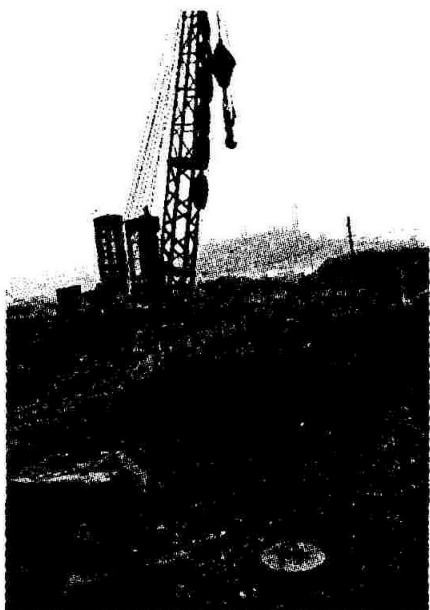
图2 强夯施工现场及施工机械
