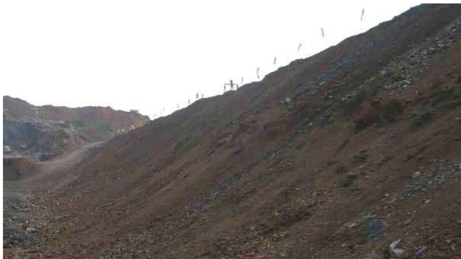
图4-4 现场高填方边坡图
